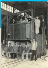
■昭和19年 日立製作所 電有工場 納入
